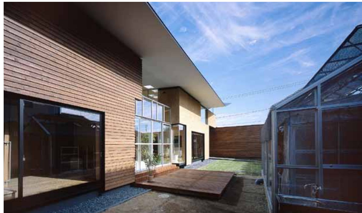
土中ダクトで結ばれた温室と母屋
