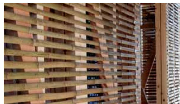
県産材のスギを使用した内壁(上) 地場の土と技術で実現した厚60mmの土壁/割り竹下地(下)
